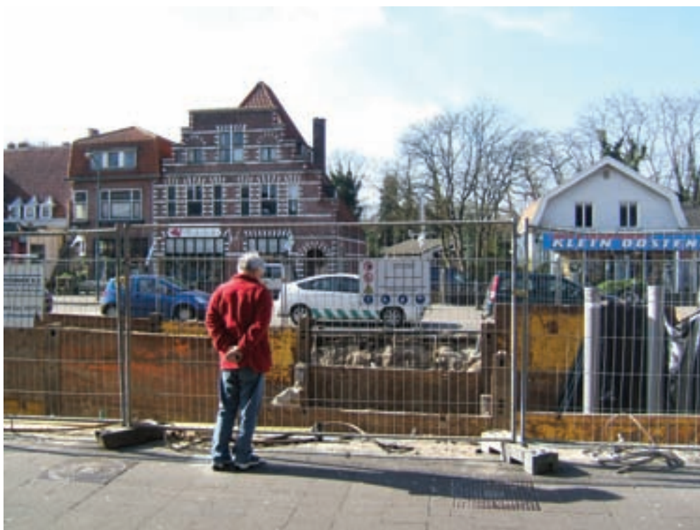
Sanering bodem- verontreiniging van voormalig benzinestation in het centrum van Bilthoven
