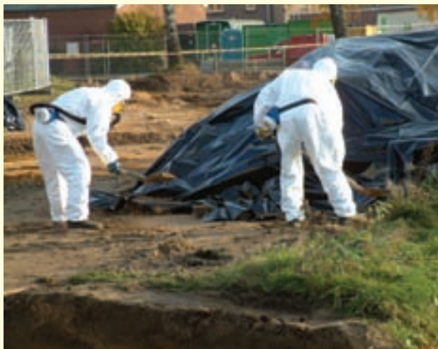
Asbestsanering in 2004 (foto: bewoners Zwanenstraat, Goor)
