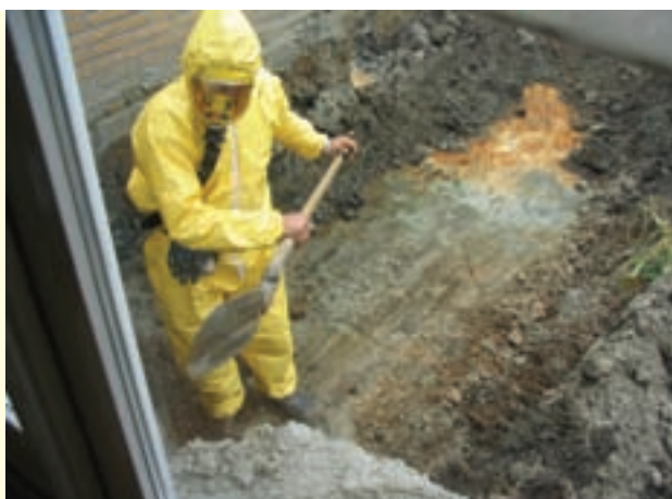
Asbestsanering in 2004 (foto: bewoners Zwanenstraat, Goor)
