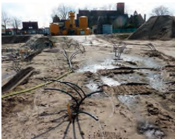
Sanering van het voormalige REGEV-gasfabriekterrein in Hilversum – leidingen voor het injecteren van Fenton's reagens
