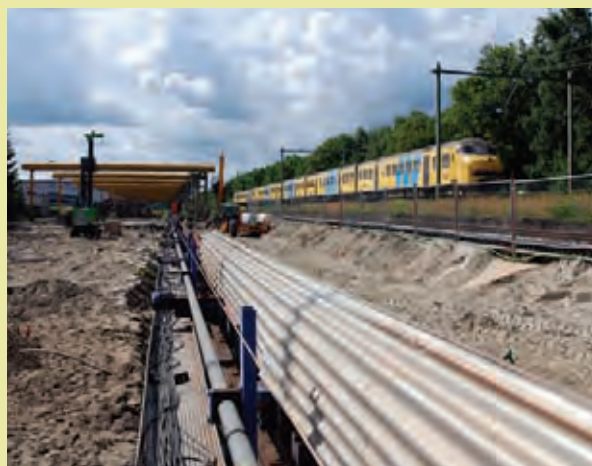
Aanleg saneringssysteem langs het spoor (Foto: SBNS)
